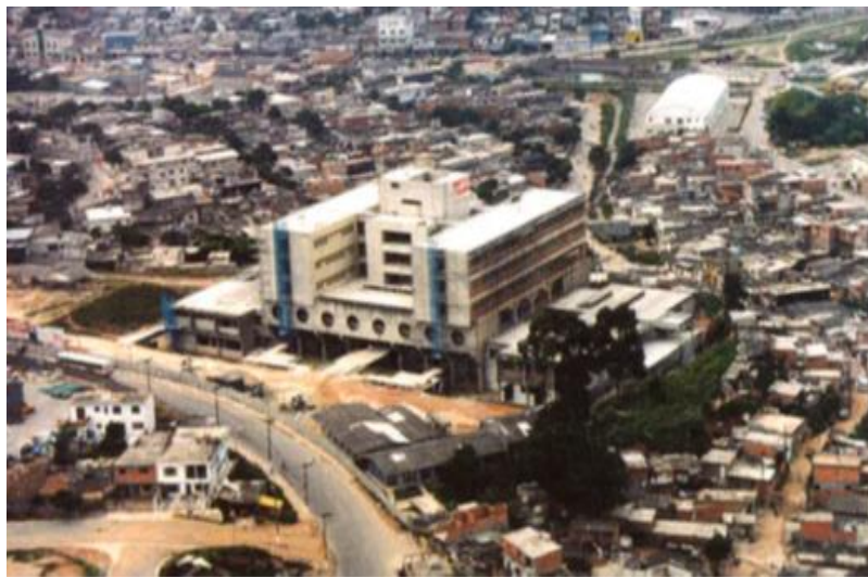
Figura 1 - Hospital Geral Pirajussara no término de sua construção no ano de 1999.
